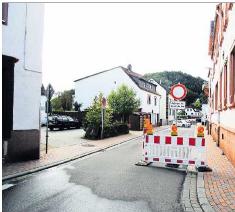
Die Hanauer Straße ist ab heute voraussichtlich bis Freitagmittag wegen Bauarbeiten gesperrt.
