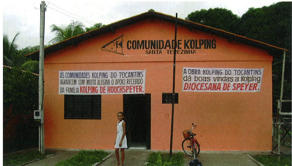
Das Kolpinhaus in Esperantina nach seiner Fertigstellung im Jahr 2009.
