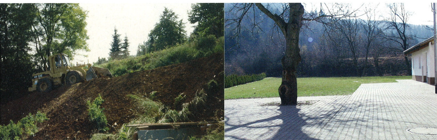
Von den großen Erdarbeiten (links) ist inzwischen nichts mehr zu sehen. Unter dem gepflasterten Platz liegt das neue Wassersammelsystem.
